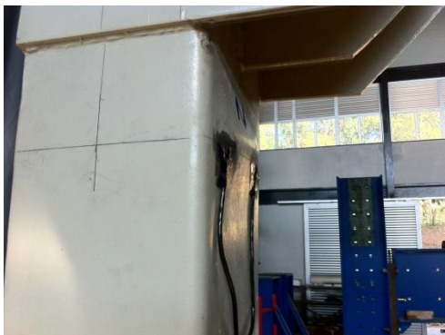
Fig. 4 - Flambagem local do perfil de aço
